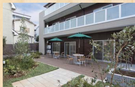
木造の有料老人ホーム(ツーバイフォー工法3階建)
